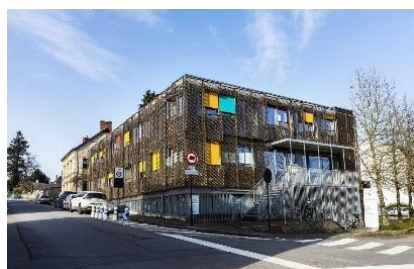
CDAS 1 rue de l'étang Saint- Aubin d'Aubigné
